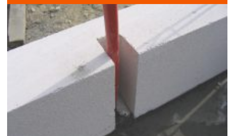
Fig. 22B: Resaque para tubería y mangueras.
