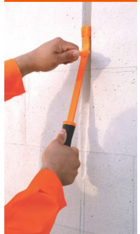
Fig. 22C: Ranurado para instalaciones de servicio.
