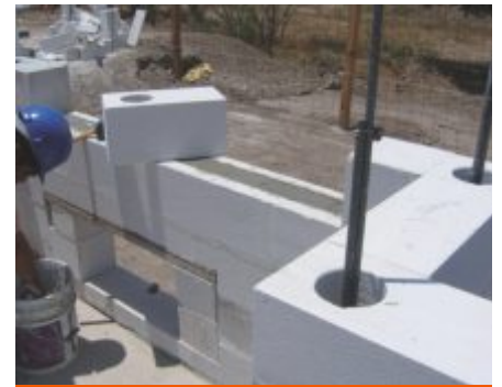
Fig. 21 Refuerzo vertical y horizontal de mampostería.
