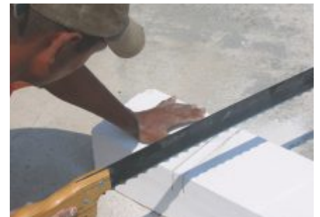
Fig. 22A: Corte con serrucho.
