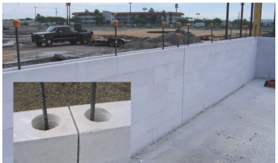
Fig. 17: Junta de control en muro.
