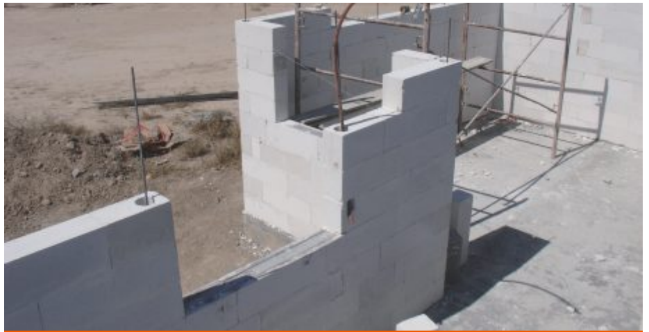
Fig. 26: Mampostería reforzada interiormente.
