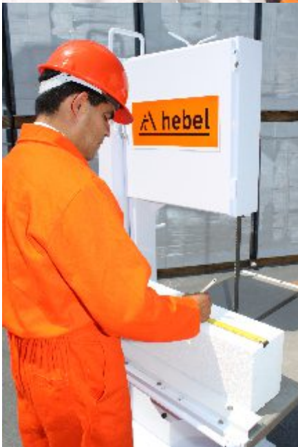
Fig. 16: Corte con serrucho y sierra eléctrica.
