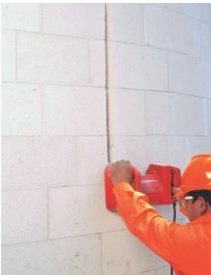
Fig. 25: Ranurador eléctrico Macroza.
